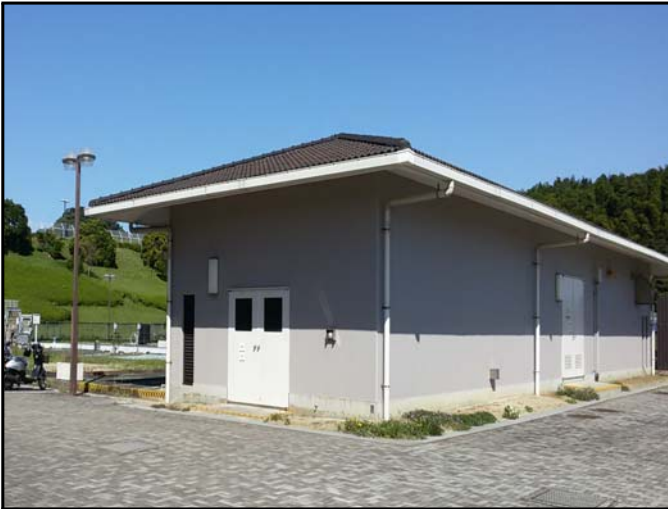
나카타 매립장 전경
