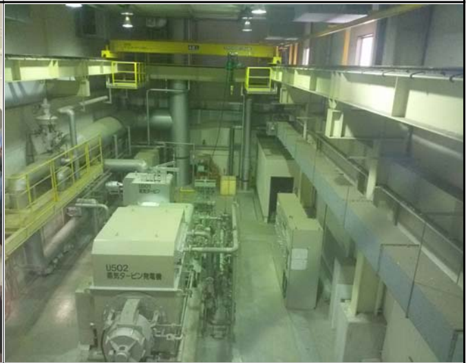
코가청소공장 소각장 현장사진 4
