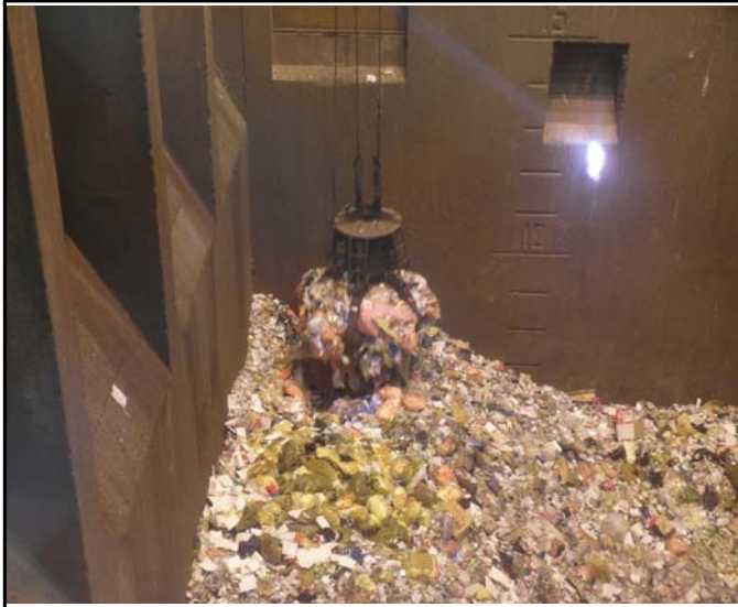
코가청소공장 소각장 현장 사진 1
